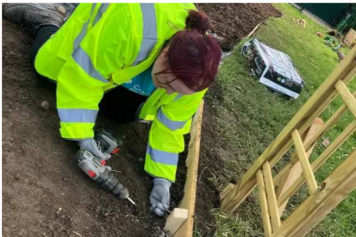
Voluntaria trabajando en la construcción del jardín sensorial.
